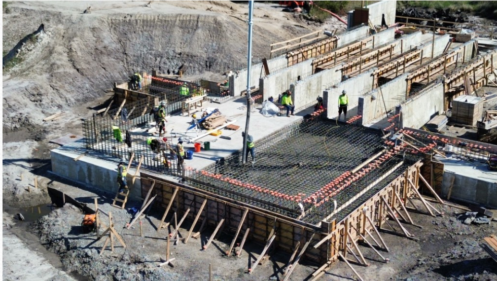
Concrete Pour on the Upper Dam Spillway Inlet Floor
